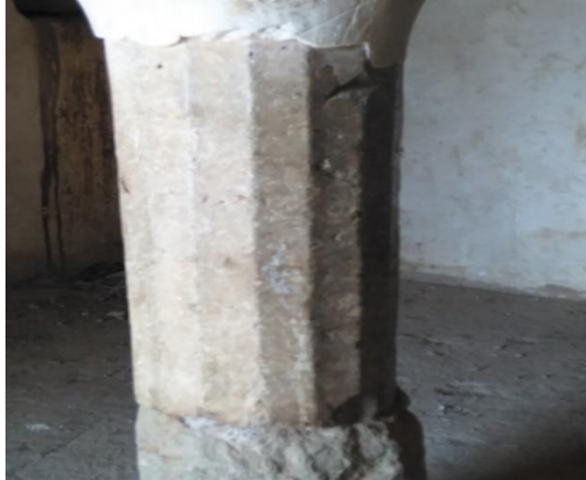
اللوحة رقم (٢١) عمود من الجرانيت (الرخام) له ستة عشر ضلع.
